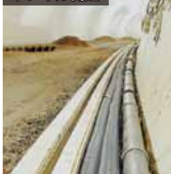
トンネル側道
